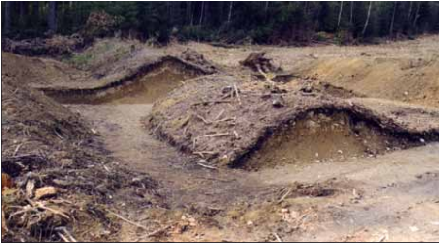
Wissenschaftliche Grabung in der Nähe des Krombacher Schlages anlässlich des Weiterbaus der B 54. Dieses Stück Wall ist heute unwiederbringlich verloren.
