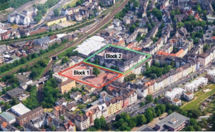
Luftbild vom Block 1+2 in Hagen-Wehringhausen, hier Block 1 nach dem Abriss
